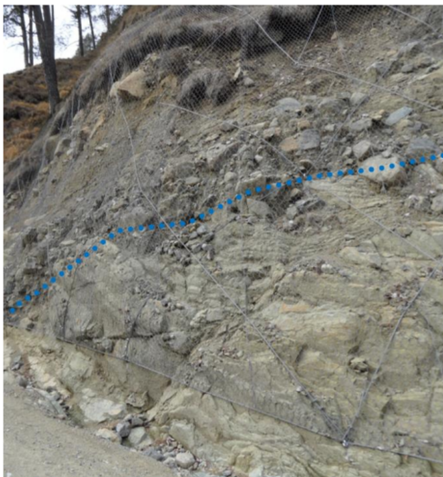
Figura 6 - Panoramica del fronte provvisorio impostato nei depositi glaciali a contatto (tratteggio blu) direttamente sul substrato compatto (2022).
