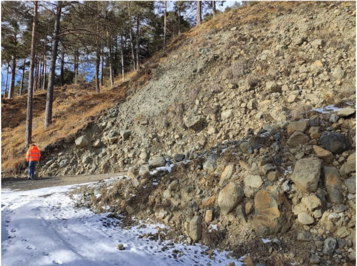
Figura 4 - Panoramica del fronte provvisorio impostato nei depositi glaciali e "impacchettato" da reti metalliche (2022).
