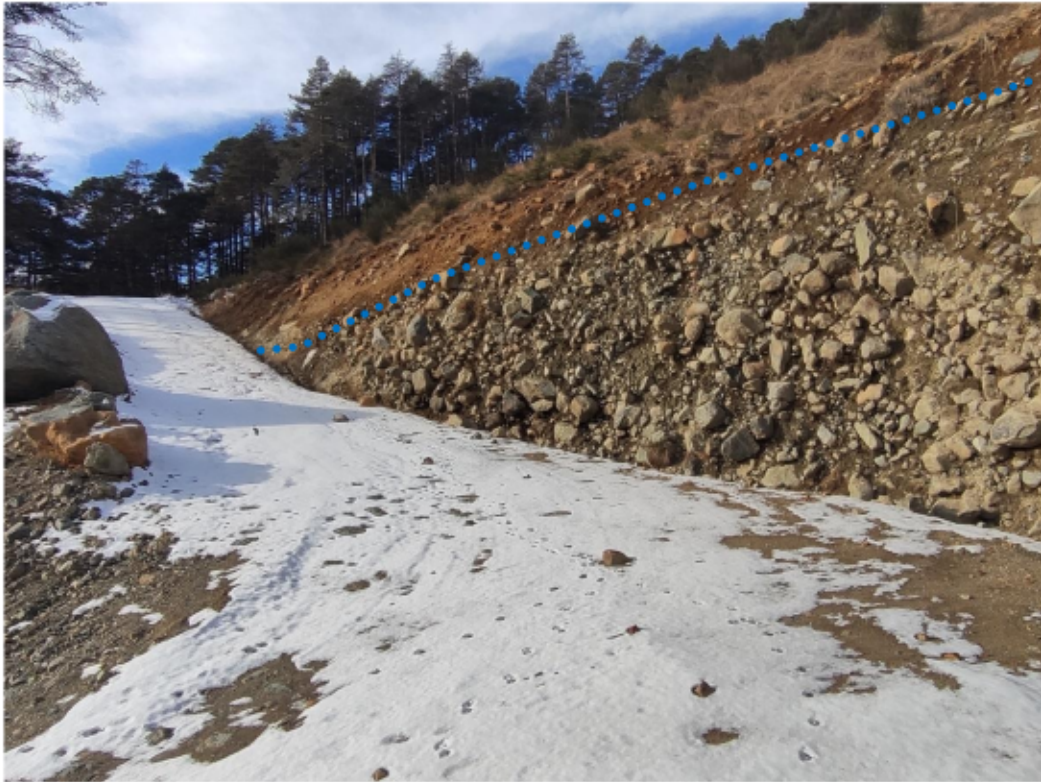
Figura 7 - Panoramica del fronte provvisorio impostato nei depositi glaciali passanti (tratteggio blu) verso l'alto alla coltre detritico colluviale (2022).
